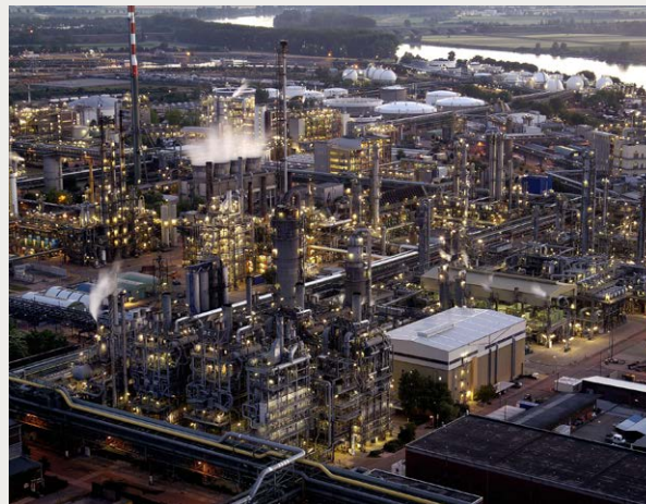
Steamcracker im BASF-Werk Ludwigshafen. Eine Fläche von rund 64.000 m 2 , das entspricht 13 Fußballfeldern, umfasst der Steamcracker II. Der Cracker ist das „Herzstück“ der Verbundproduktion. Er spaltet unter Zusatz von Wasserdampf bei etwa 850 Grad Celsius Rohbenzin auf. Dabei entstehen im wesentlichen Ethylen und Propylen – wichtige petrochemische Grundstoffe u.a. in der Herstellung von Kunststoffen (2014). BASF – We create chemistry, flickr (CC BY-NC-ND 2.0: https://www.flickr.com/photos/basf/15970578176/ ).
